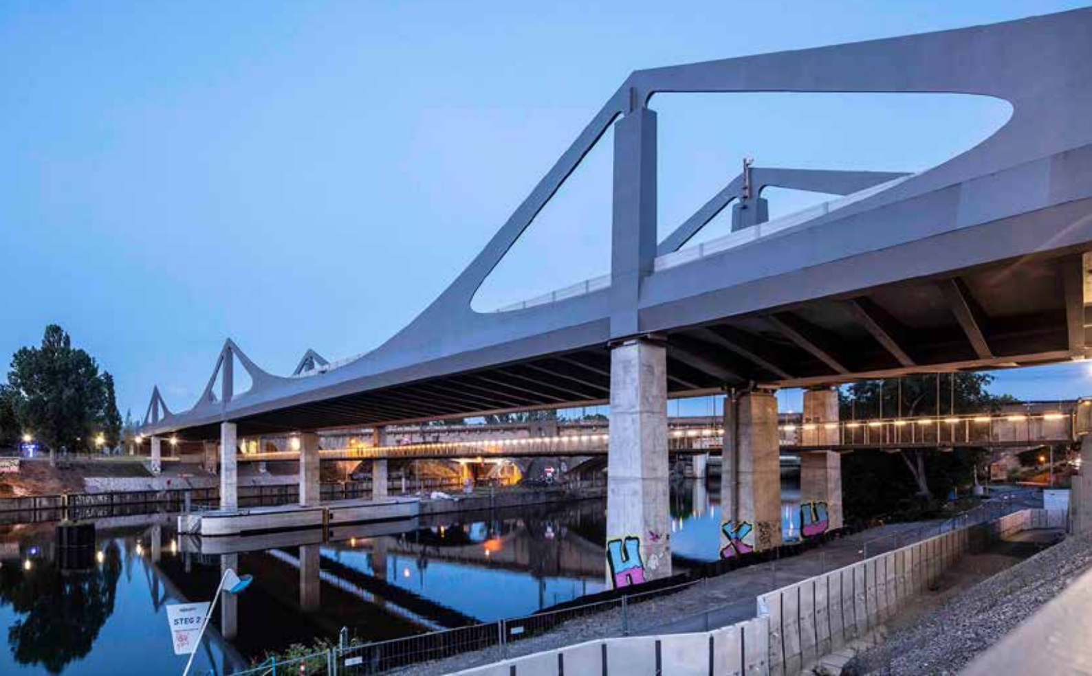
Abb.: Die neue Neckarbrücke ist eines der markantesten Infrastrukturbauwerke im Rahmen von »Stuttgart 21«. Die Stahlsegel auf der Brücke sind filigran gestaltet und sorgen dafür, dass das Lichtraumprofil unter der Brücke offen bleibt und freie Sichtachsen bietet.
