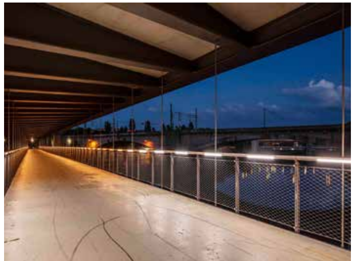
Abb.: Nachts wandern dynamische Lichtimpulse aus kaltweißem Licht durch die warmweiße Beleuchtung des Stegs. Die Lichteffekte sind von der Straße aus kaum wahrnehmbar, aber durch die Reflexion der Decke umso eindrucksvoller.
