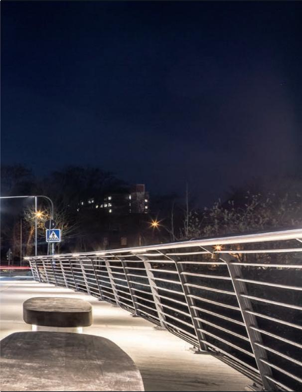
Dynamisch, schlank, fast schwebend: So präsentiert sich die imposante Fachwerkbogenbrücke seit ihrer Eröffnung. Nahezu unsichtbar wurden dafür auf 42 Metern und aus einer Höhe von 1,10 Metern robuste LED-Lichteinsätze instalight 4020 in die Handläufe integriert. Nachts entsteht so eine angenehme und blendfreie Lichtverteilung auf den Verkehrswegen für Fußgänger, Radfahrer und Kraftfahrzeuge. Tagsüber sind die Beleuchtungskörper unsichtbar, dank bündigen Einbaus im Handlauf-Nutrohr.
